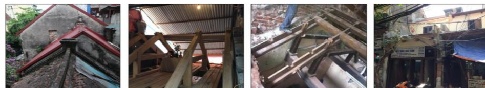
QUÁ TRÌNH THI CÔNG 2013 - 2014 EN CHANTIER 2013-2014
