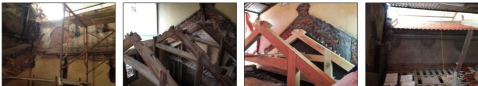
QUÁ TRÌNH THI CÔNG 2013 - 2014 EN CHANTIER 2013-2014
