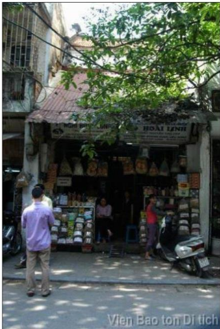
HIỆN TRẠNG CÔNG TRÌNH THÁNG 5/2013 AVANT LE PROJET 5/2013
