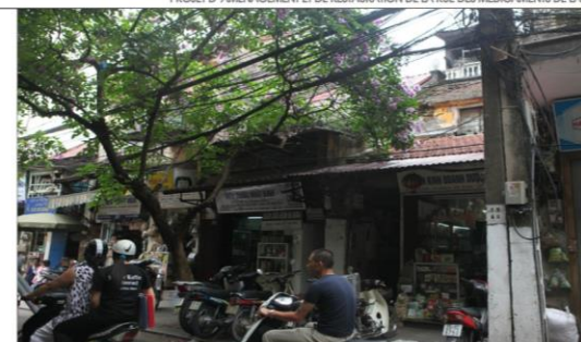
HIỆN TRẠNG CÔNG TRÌNH THÁNG 5/2013 AVANT LE PROJET 5/2013
